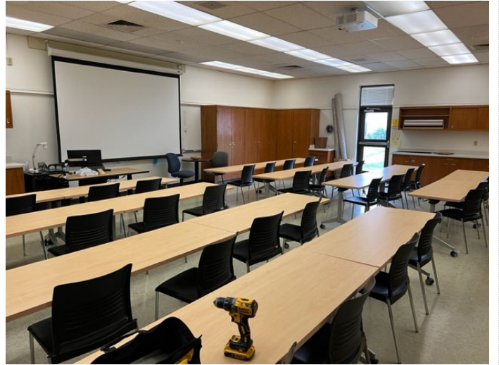
9" VFT Brown & Mastic-Asbestos
